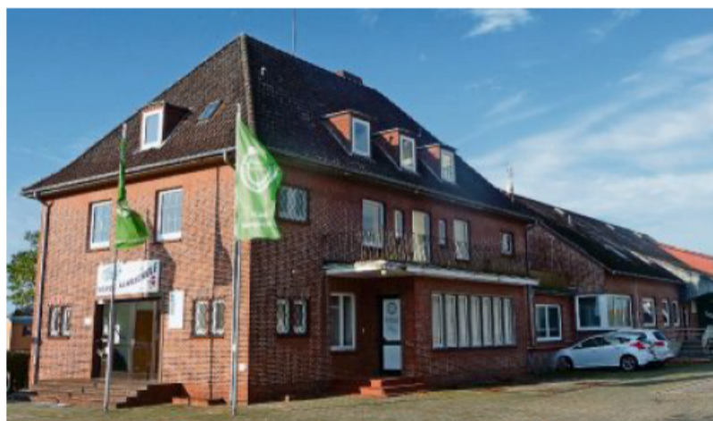
Vor dem Abriss: das ehemalige Gebäude einer Bremervörder Fahrschule mit angebauter Halle.
