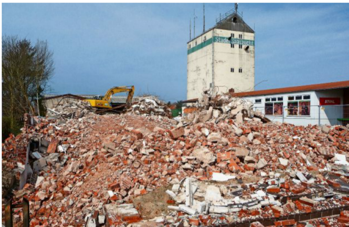
Noch steht der Siloturm , der in den nächsten Wochen ebenfalls abgerissen wird.
