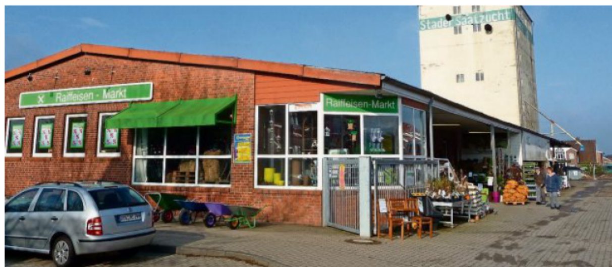
Der Markt und der Siloturm werden ebenfalls noch abgerissen, damit an gleicher Stelle der neue Raiffeisenmarkt entstehen kann.
